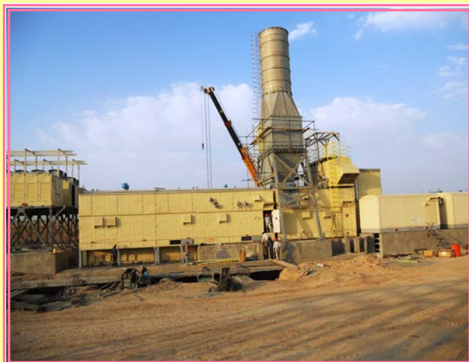
پایان عملیات نصب و مونتاژ توربو کمپرسور ایستگاه سراج
