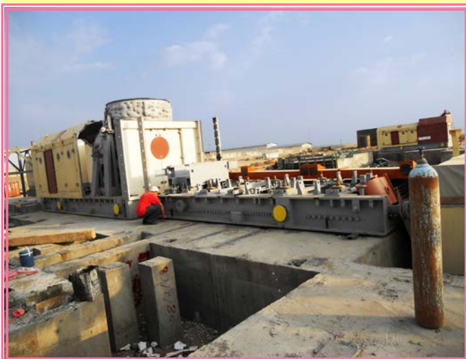
شروع عملیات نصب و مونتاژ توربو کمپرسورهای ایستگاه سراج به با نظارت پالایش سبز
